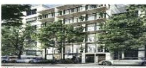
Vecinos denunciaron que fueron construidos pisos extra en Oaxaca 13 sin los permisos legales.
