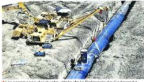
Un segmento del ducto, atrás de la Refinería de Cadereyta, es sostenido por dos grúas para apenas ser unido ayer.
