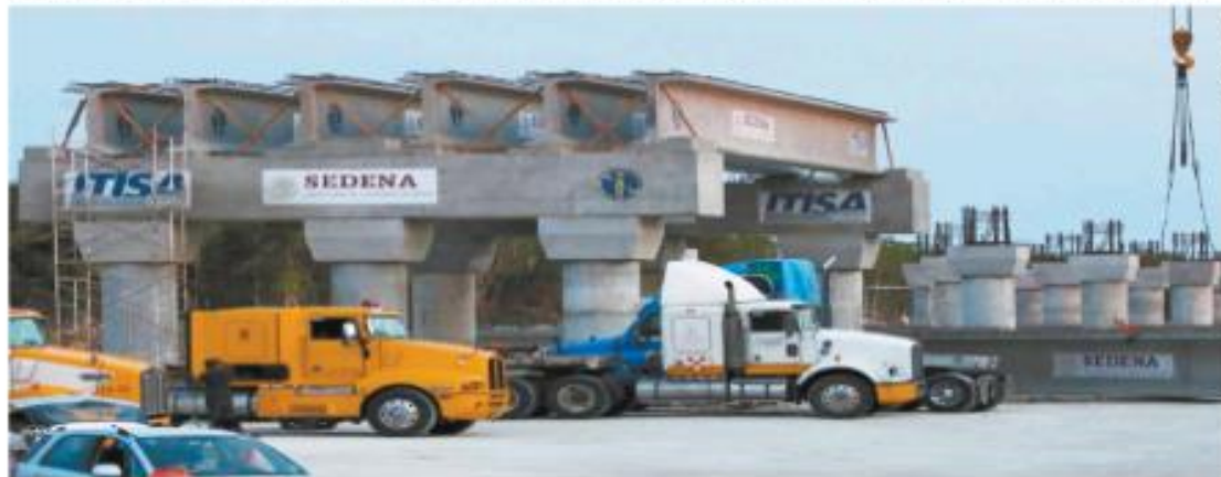
En diversos puntos de las estructuras de concreto se exhibe el logotipo de la Secretaría de la Defensa Nacional.
