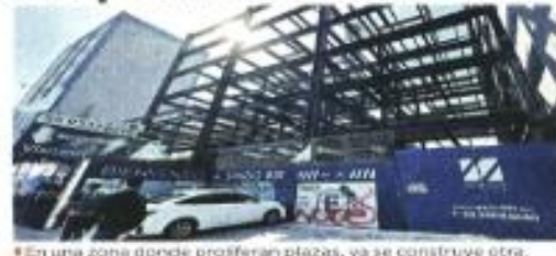
En una zona donde proliferan plazas, ya se construye otra.
