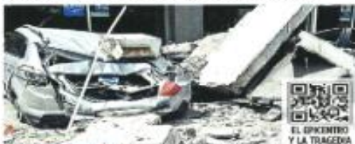
MANZANILLO. El derrumbe en una plaza provocó la muerte de una mujer y daños en varios vehículos.
