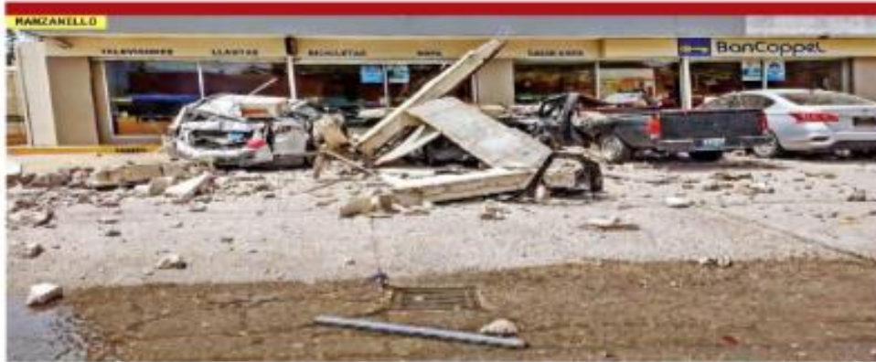
Parte de la fachada de una tienda departamental en Manzanillo, Colima, se desprendió y cayó encima de un hombre, el cual falleció. Foto: Agencias
