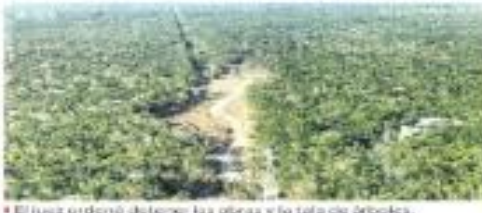
El juez ordenó detener las obras y la tala de árboles.
