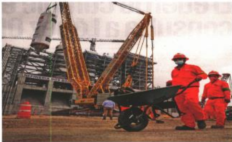
En el complejo operan más de 32 mil trabajadores para concluir la refinería Cimac antes de su inauguración, el próximo 2 de julio. El avance en la construcción hasta ahora es de 90%.
