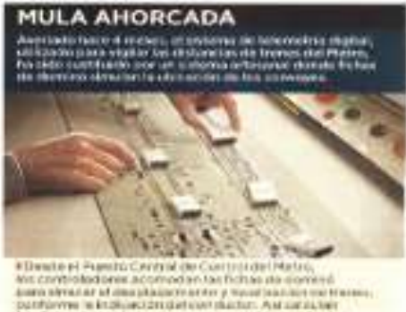
El Puesto Central de Control del Metro, los controladores acomodan las fichas de dominó para operar el sistema de control de los trenes. Por ahora se utilizan fichas de dominó para controlar las distancias entre los trenes para evitar accidentes.
