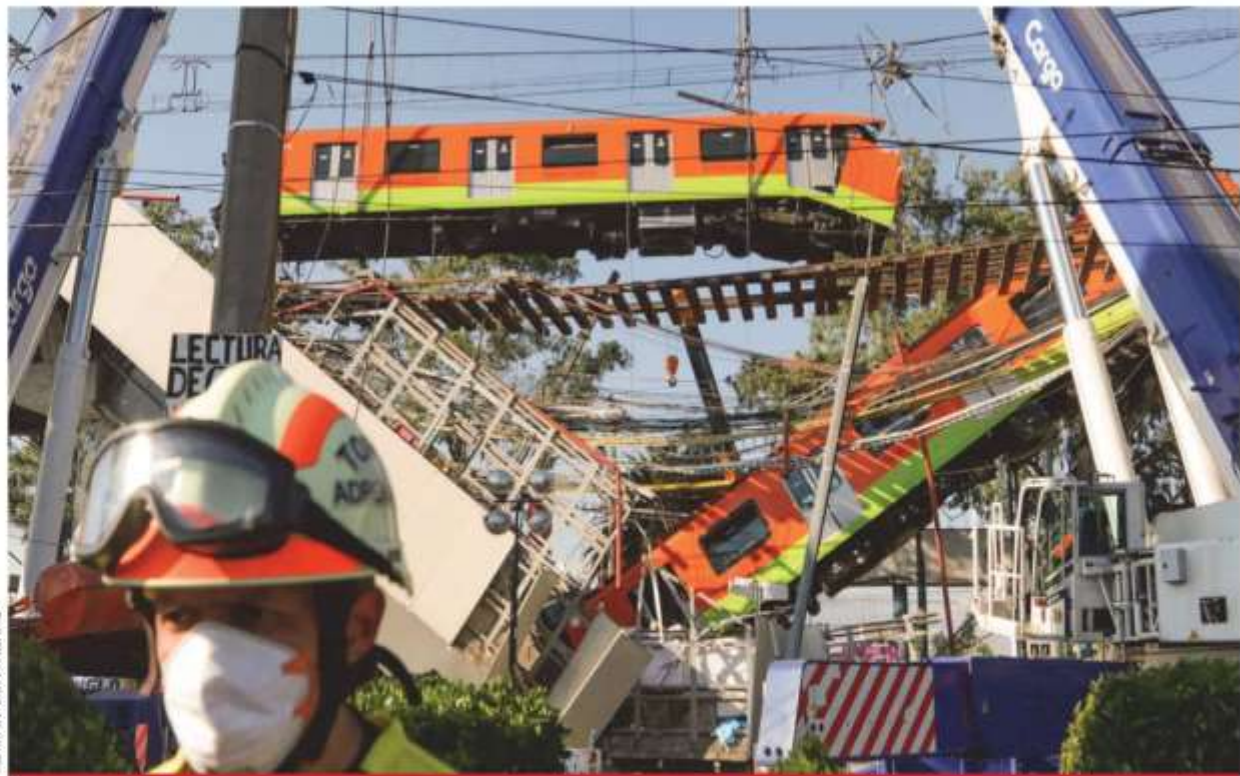
Gigantescas grúas movieron del lugar del accidente a los dos vagones desplomados de la Línea 12 en la estación Olivos
