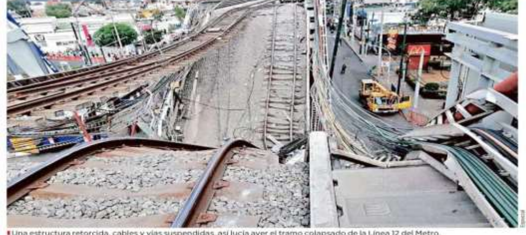
Una estructura retorcida, cables y vías suspendidas, así lucía ayer el tramo colapsado de la Línea 12 del Metro.
