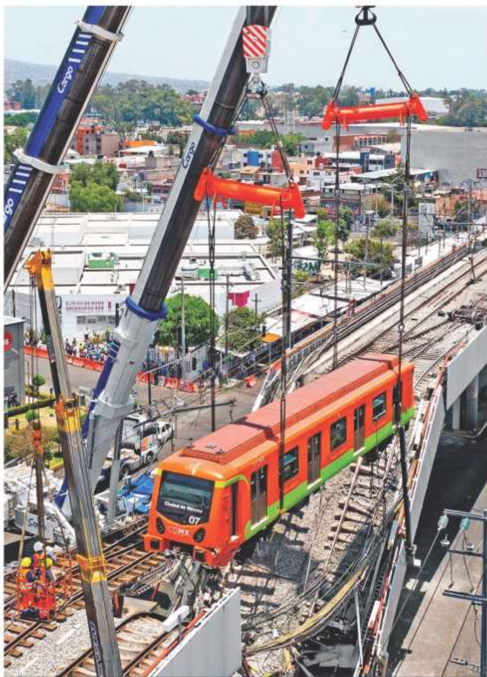
MANIOBRAS. Dos grúas, una de 500 toneladas y otra de 700, proporcionadas por la empresa Cargo, fueron necesarias para retirar los vagones siniestrados en el desplome de un tramo elevado en la Línea 12.
