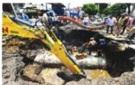
Personal de Sacmex y Protección Civil trabaja en la reparación del coyoacán que se abrió en Ciudad de Mérida.
