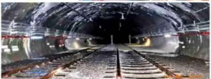
Entre los cadenamientos 29+260 al 29+280 se presentan graves problemas de filtraciones, escurrimientos y goteo de agua en la bóveda y paredes del túnel.
