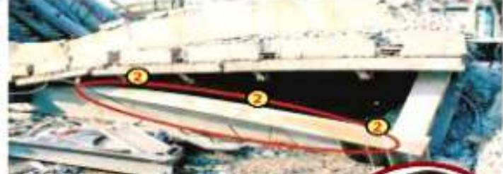
1. Los pernos Nefos son piezas metálicas que unen traveses de acero y bases de concreto para hacer una sola estructura monolítica. 2. En el portique se observó que el número de pernos no coincidía con la señalado en los planos de diseño. Foto: Euronews
