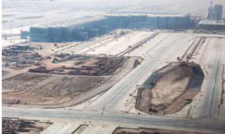
VISTA de los trabajos finales desde la Torre de Control, ayer.
