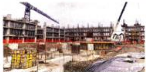
Avance de las obras en Dos Bocas hasta el 21 de agosto.
