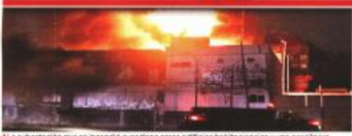
En la subestación que se incendió ayer tiene cerca edificios habitacionales y una gasolinera.
