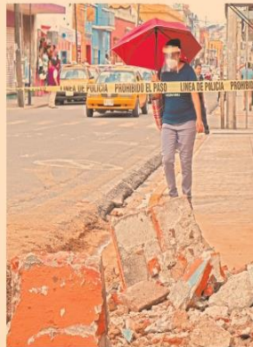
Bloques. En Oaxaca, algunos muros cayeron sobre las aceras. FOTO: REUTERS
