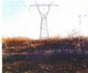
Las estructuras de las torres de transmisión no muestran signos de daño por fuego.
