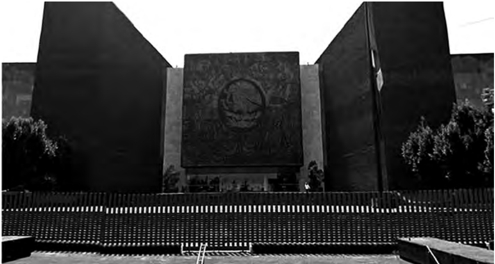
Edificio de San Lázaro, sede de la Cámara de Diputados en la Ciudad de México.
